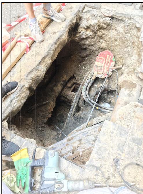
Final de l'excavació al carrer, prèviament al desmuntatge de l'arqueta de maons
