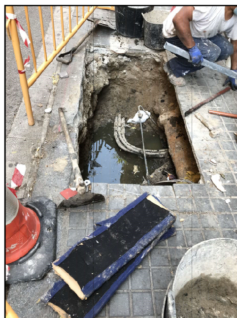
Inici de l'excavació al carrer
